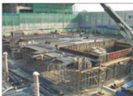
답십리 주택 재개발 신속공사 현장
