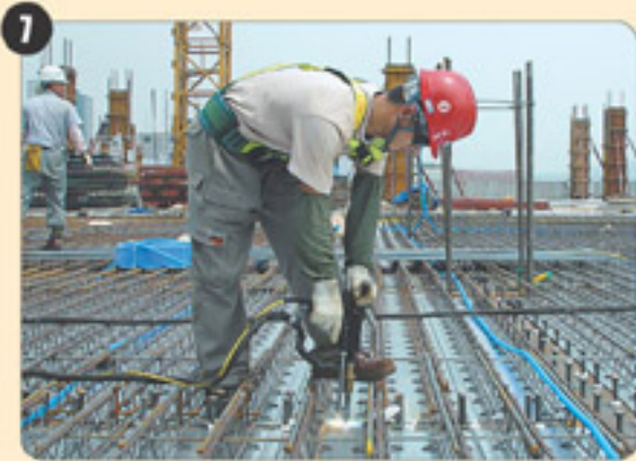
7 Stud Bolt 작업
