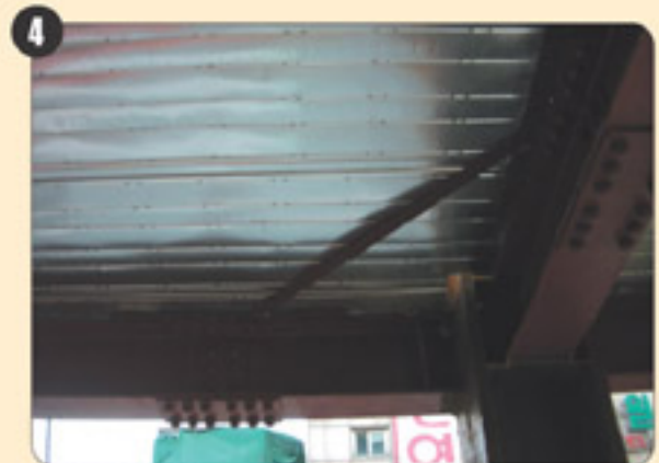
4 기둥주위 보강 Angle설치
